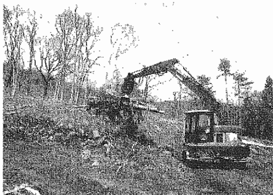
写真 重機による地拵え状況
