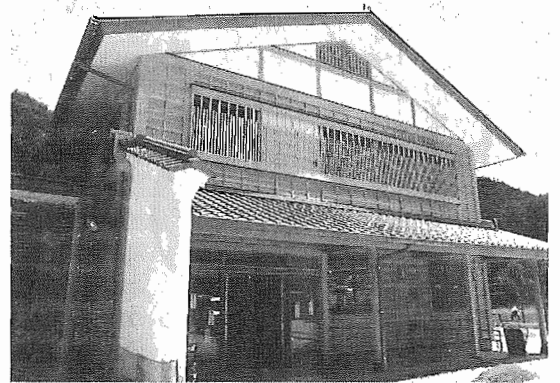
写真1 公共建築の木造化--秩父消防署北分署
