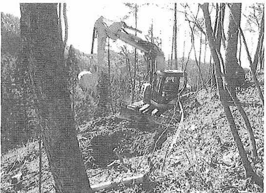
放射性物質対処型研修 表土埋設のための掘削作業
