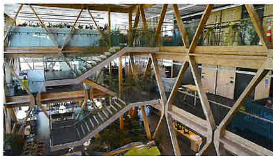
三角形の梁が連続する本部棟「Te Whare Nui o Tuteata（トゥテアタの大きな家）」。耐震性に配慮した斬新な構造と高いデザイン性が評価され、国内外の建築・デザイン賞を多数受賞している。
