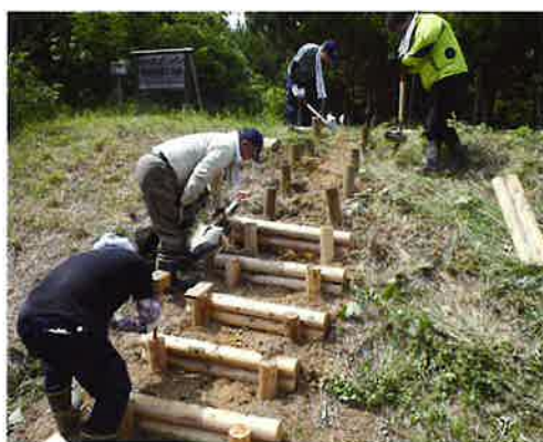
階段補修作業の様子
