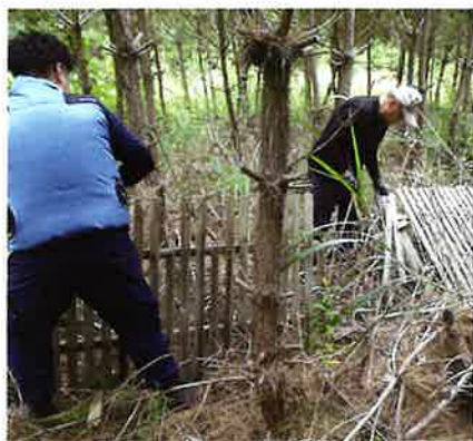
防風垣の撤去作業の様子
