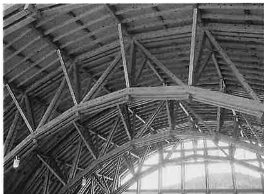
大天井の小屋組みは、挟み梁とトラスの応用
