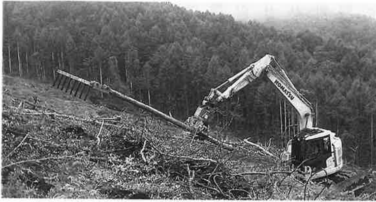
グランドレーキによる地拵え作業
