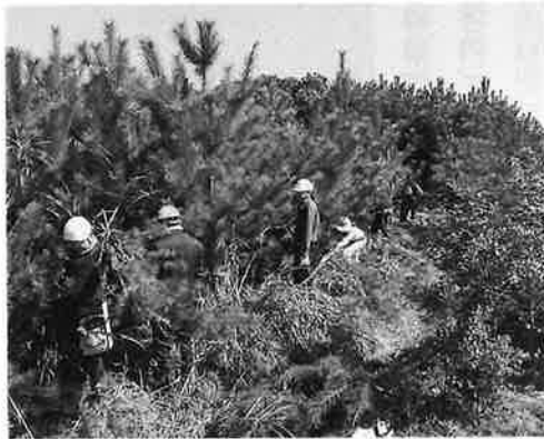
裾枝払い作業の様子
