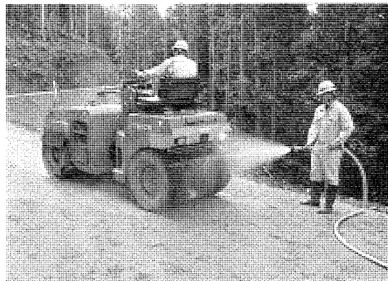
散水・転圧により固化し、時間経過で強度が増す
